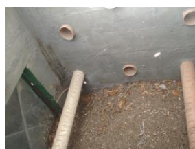
Parte interna deste sistema de alvenaria imagem da autora
